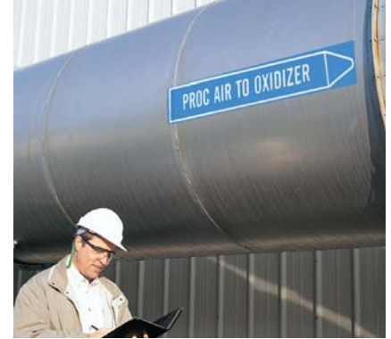
Marquage de tuyauteries
